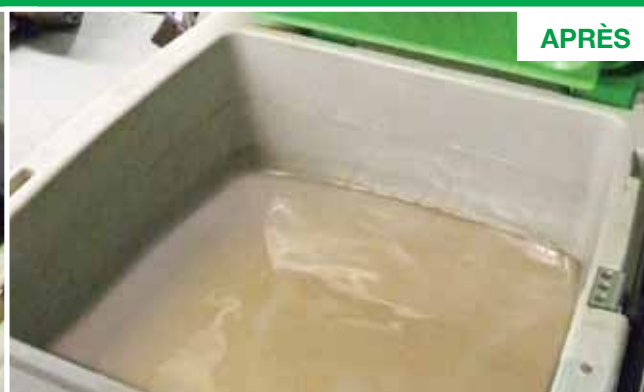
Le réservoir après le Service CARE.
