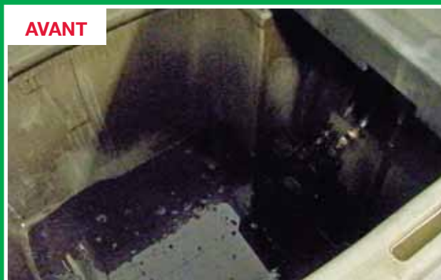
Le réservoir de BIO-CIRCLE après le drainage mais avant le nettoyage.
